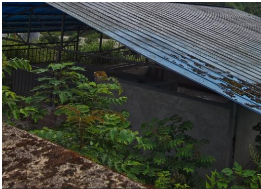
气田水池（相 9 井）
