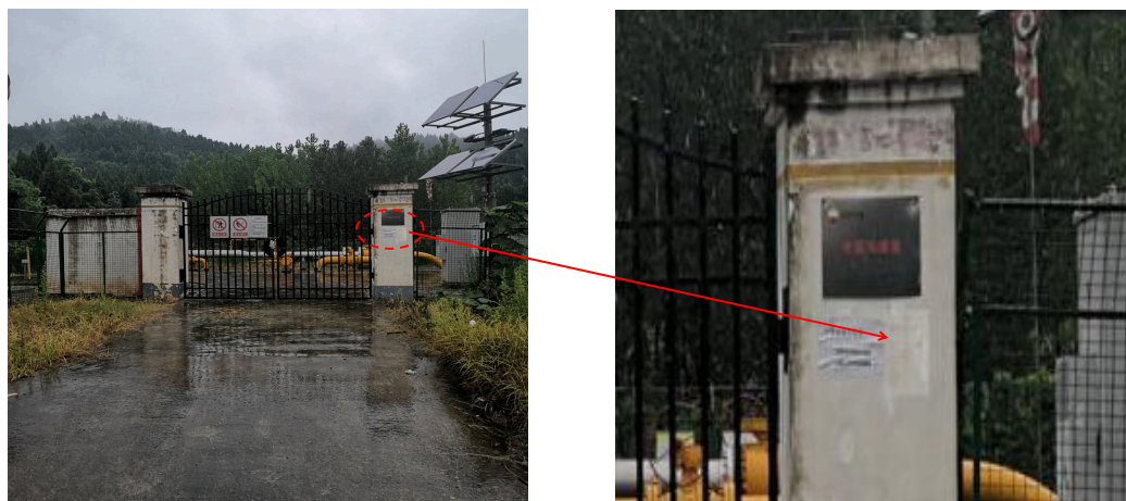
图5 木顶沟阀室门口处现场公示
